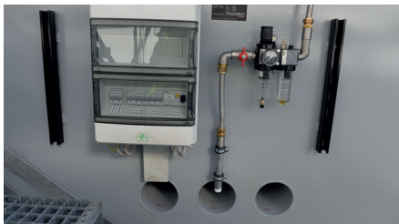
Alle erforderlichen Versorgungsleitungen werden verlegt und angeschlossen.
