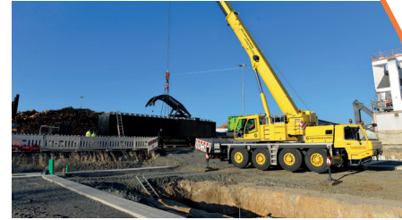
Die TRUCKBAY wird an einem Stück mittels Kran an ihren Bestimmungsort gehoben.
