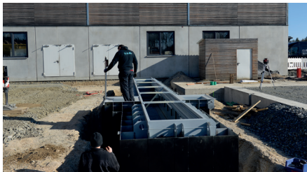
TRUCKBAY wird ausnivelliert vor dem Vergießen.
