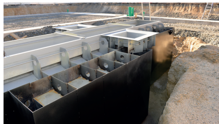
Füllen der Doppelwand mit Beton, um die nötige Stabilität zu erlangen.
