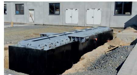
Nach dem Aushärten des Betons kann der Grubenkörper eingegossen werden.
