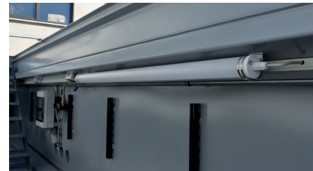
LED-Rohrleuchte, 1630 mm lang, 3800 lm
