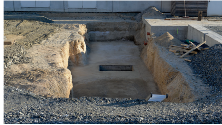
Die Sohlplatte wird bauseitig nach Vorgabe betoniert.
